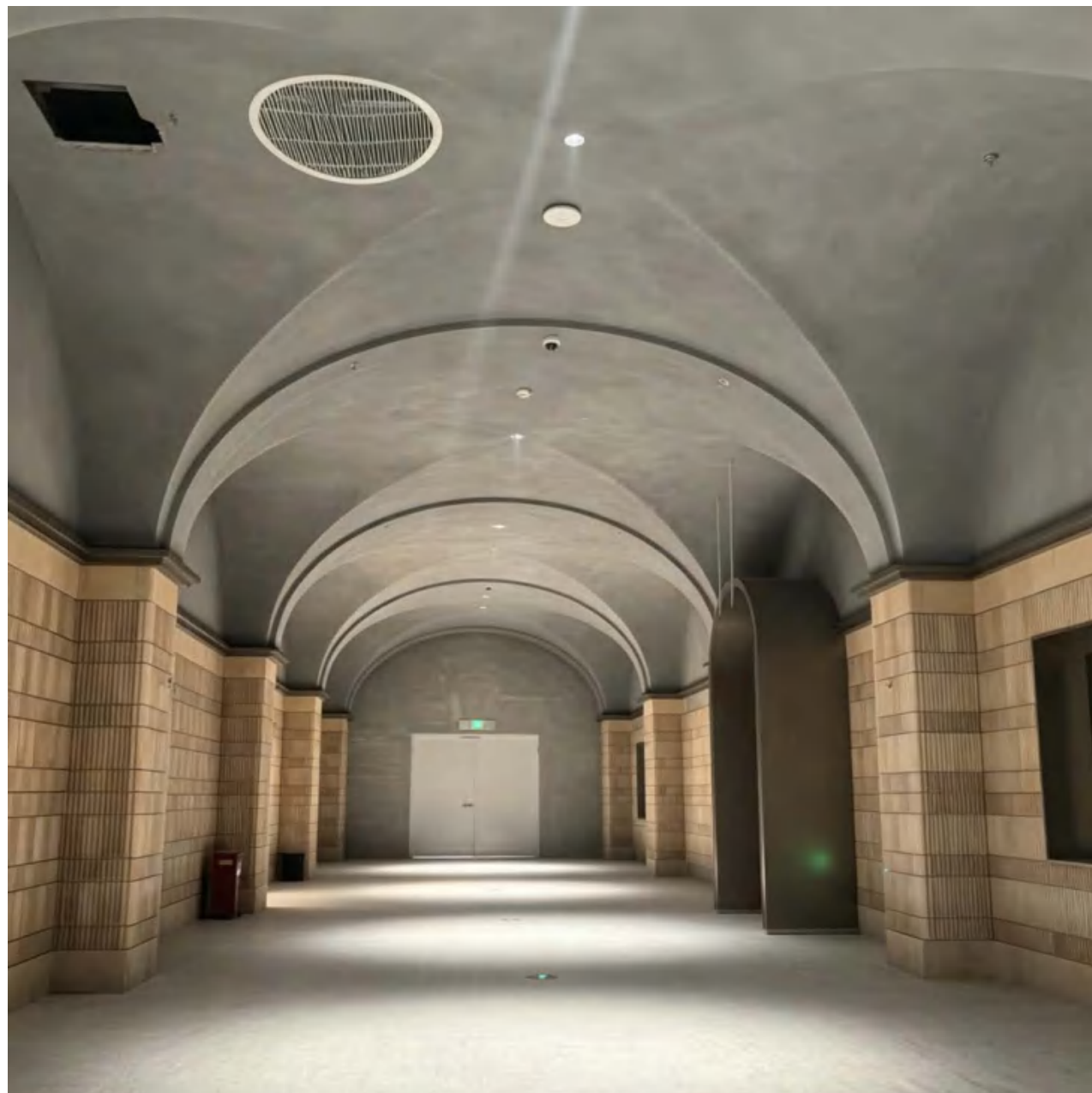
阿里影院走廊吸音吊顶
